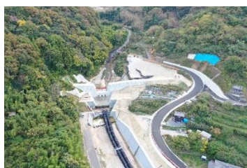
写真-12〔下流側から撮影〕
