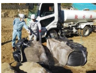
写真-3[コンクリートキャンバス試験施工]
