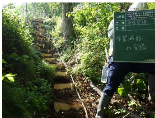
【写真 - 6】 斜面移動用通路 階段設置
