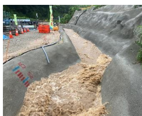
写真-5[仮水路出水時]
