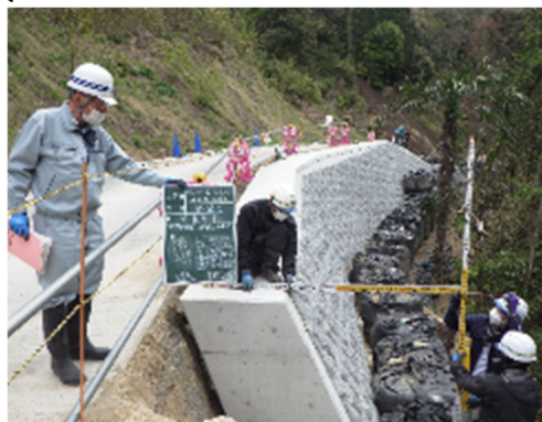
図-16 段階確認を行うベトナム人エンジニア
