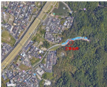
図-1 工事場所（航空写真）
