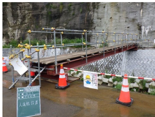
【写真 - 5】 仮設 H 鋼人道橋
