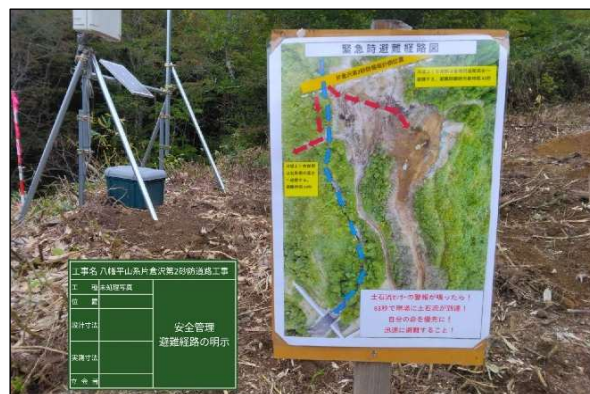
写真-3 避難経路図の設置
