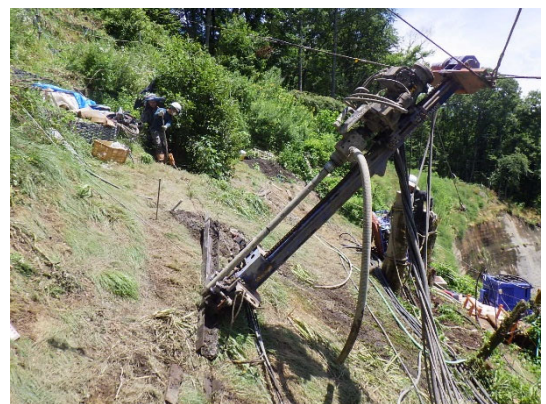
【写真 - 3】 SD 工法(無足場鉄筋挿入工)
