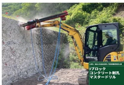
【写真-9 削孔状況】
