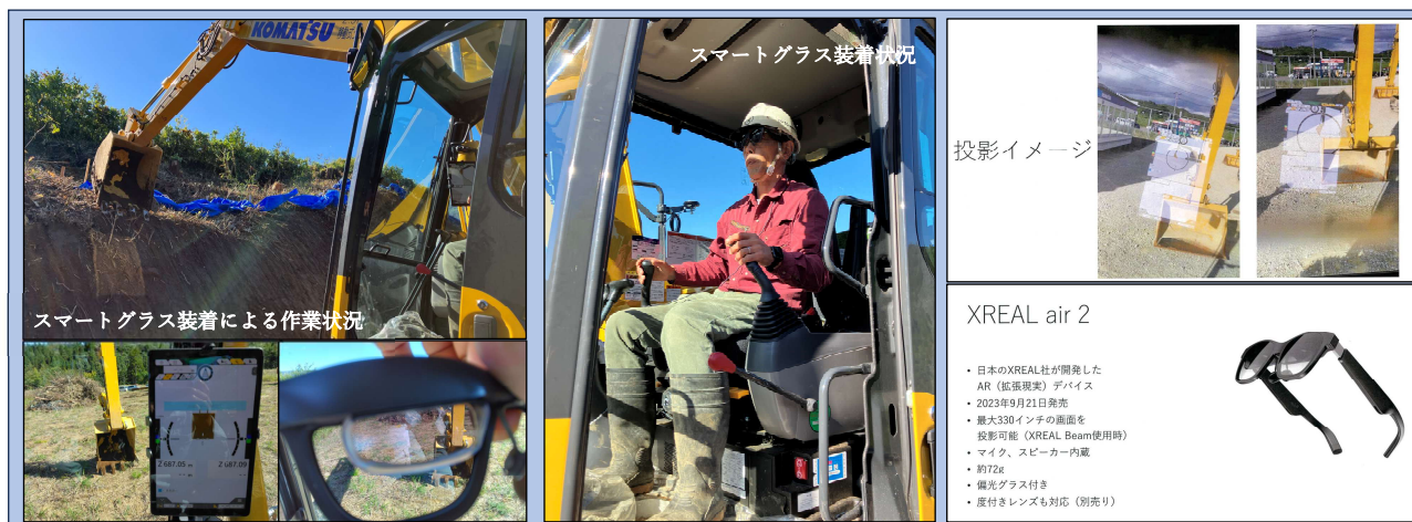
写真-12 スマートグラスの活用
