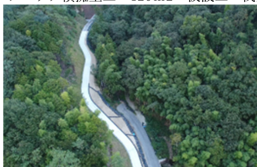
図-3 着工前 ドローン撮影
