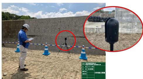
写真-4 TLS 計測状況
