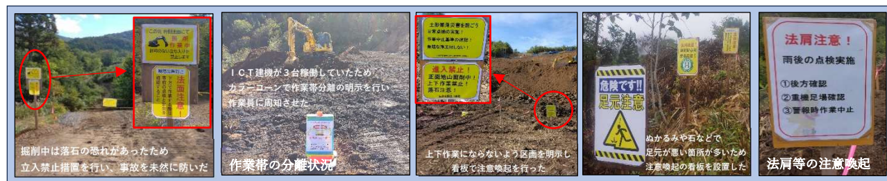
写真-5 注意喚起看板等の設置
