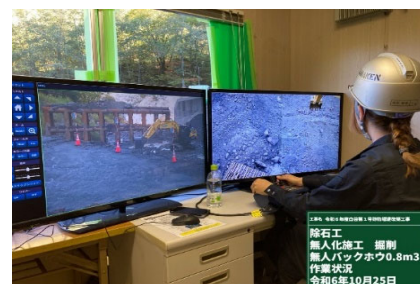
【写真-5 無人化施工掘削状況】
