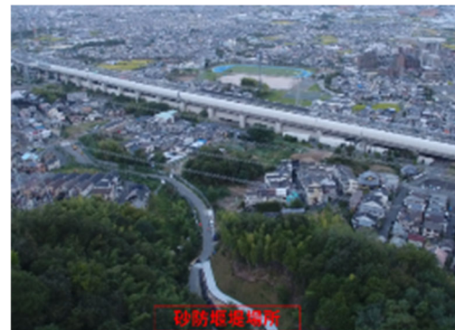
図-2 砂防堰堤予定地の下流には住宅が密集している
