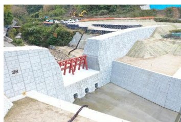
写真-13〔右岸下流側から撮影〕
