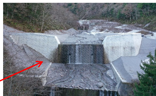
【写真-2 白谷第1号砂防堰堤 令和6年度 完成】
