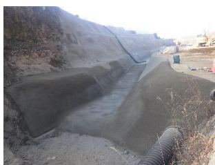
写真-4[モルタル吹付施工]
