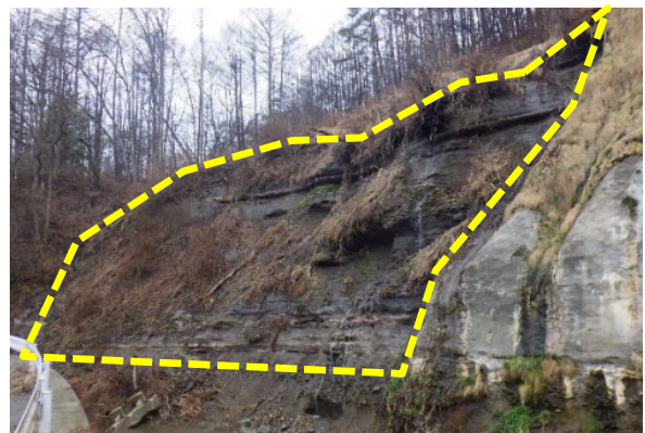
【写真 - 2】 黄点線内 高所法面掘削範囲
