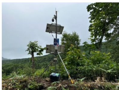
写真-2 ウェブカメラの設置
