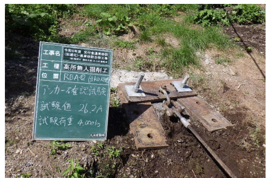
【写真 - 4】 控えアンカー耐力確認試験
