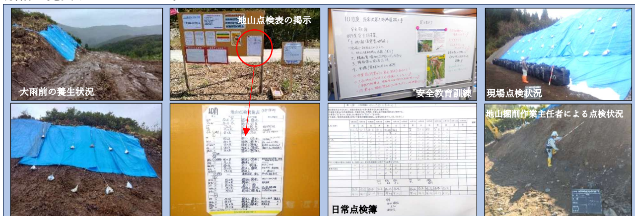
写真-9 土砂崩落災害防止の安全対策
