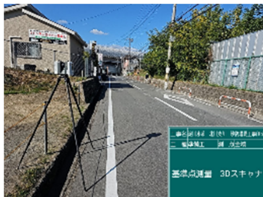
図-8 TLSによる基準点測量 ワンマンでも作業可能
