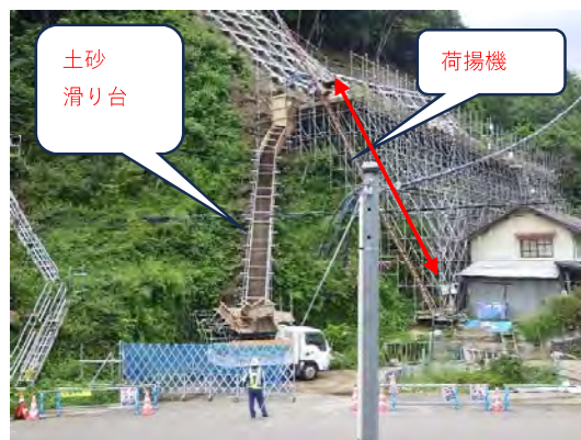
写真-5 土砂滑り台利用状況 荷揚げ機設置
