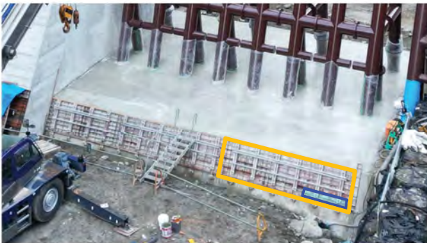
橙：大盤型枠(4.5m×1.2m) 青：単品(1.5m×0.3m)
