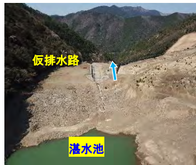
写真 2. 河道閉塞 (上流より)
