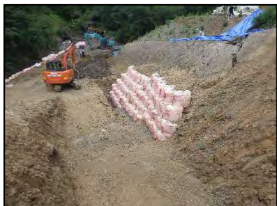
写真-14 土のう積による土留
