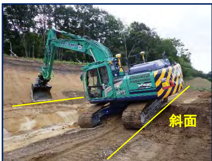
写真-18 3D-MC 機チルトローテータ付 BH
