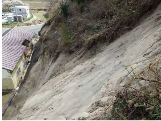
写真-3 崩落斜面現況2
