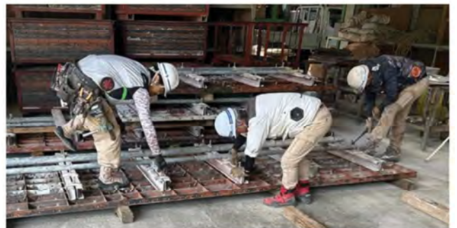
②屋内大盤型枠組立の様子
