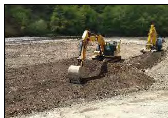
写真-20 ICT 施工
