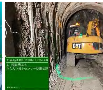
写真6. 重機作業半径
