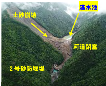
写真 1. 河道閉塞 (下流より)
