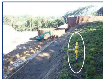
写真-20 スーパーサッチャー設置
