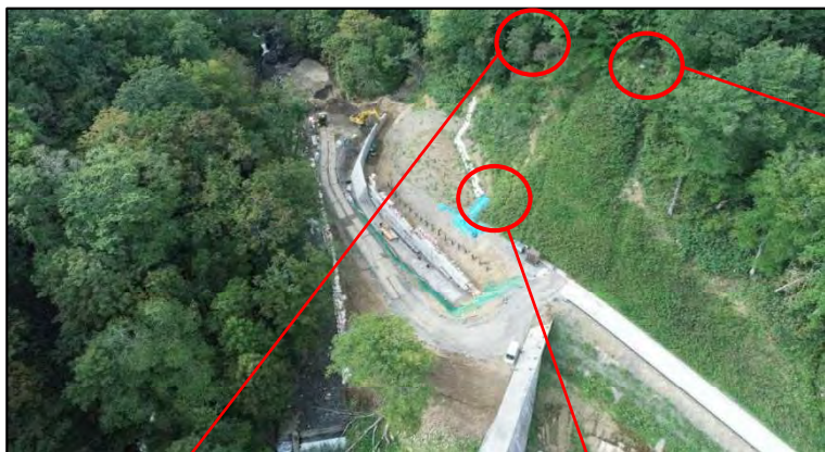
写真-8 観測機器配置全体
