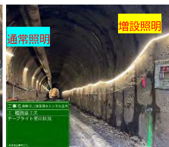
写真8. 坑内照明増設
