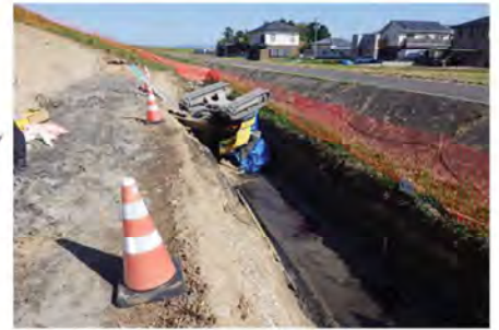
事故時の作業状況
