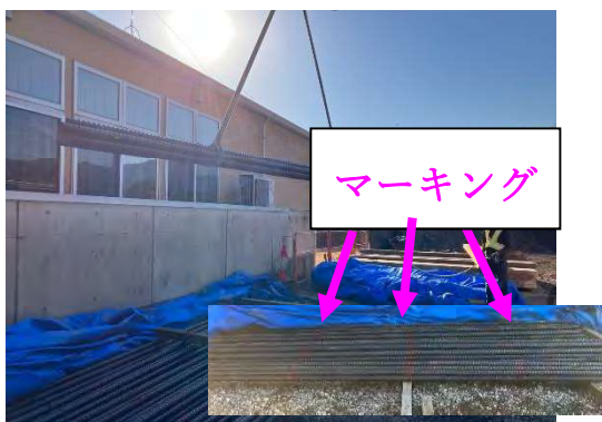
写真4 玉掛箇所のマーキング（運搬前）
