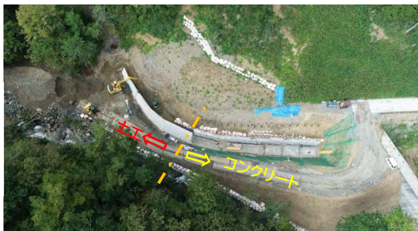
写真-7 コンクリートと土工を平行して施工
