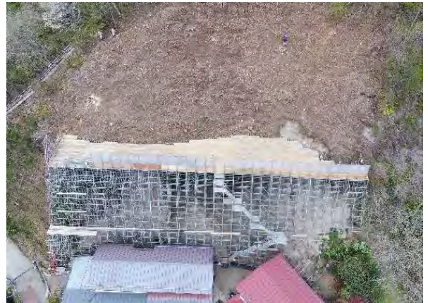
写真-4 作業構台全景
