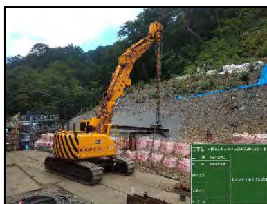
写真-15 リーダレス工法
