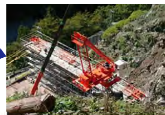
現場施工状況
