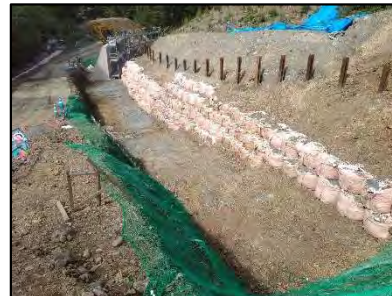
写真-16 抑止杭施工完了
