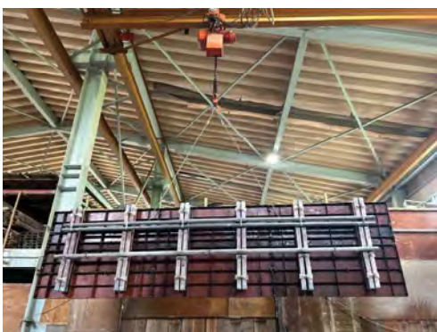
大盤型枠はクレーンで吊り上げ可能
