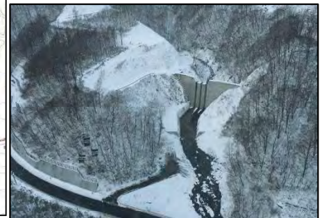
写真-1 シガクラ沢砂防堰堤
