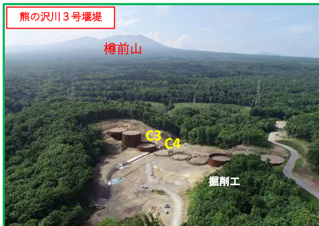
写真-1 樽前山と熊の沢川3号砂防堰堤
