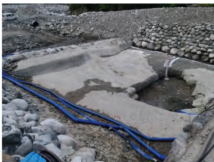
写真-1 黒蘆川第4号砂防堰堤(着工前)
