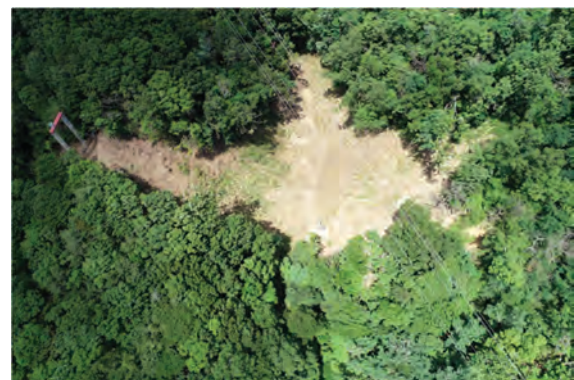
写真-1 工事着工後(伐採完了)
