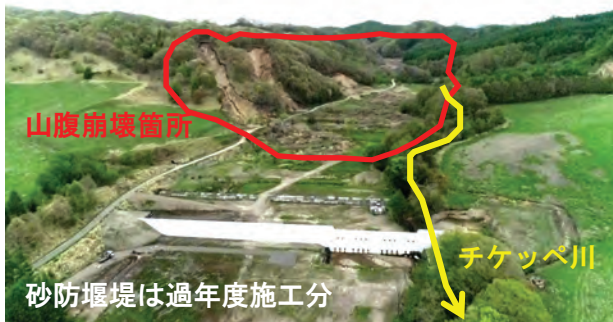
写真-1 砂防堰堤施工箇所周辺状況
