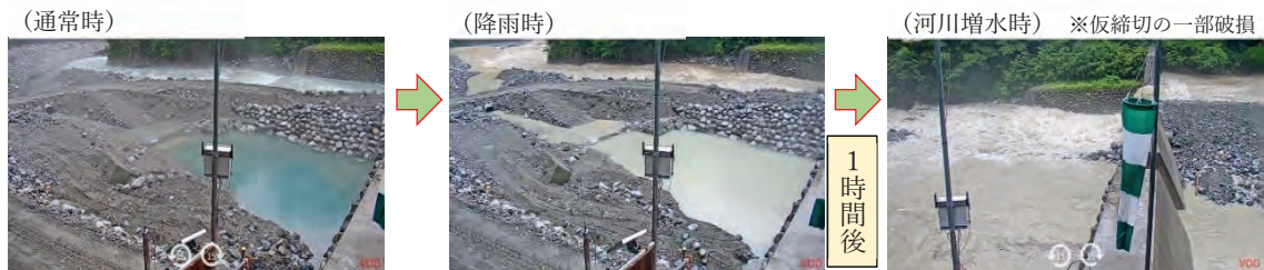
写真-4 降雨時の河川増水状況（黒薙川第4号砂防堰堤）（2020年6月 出水）
