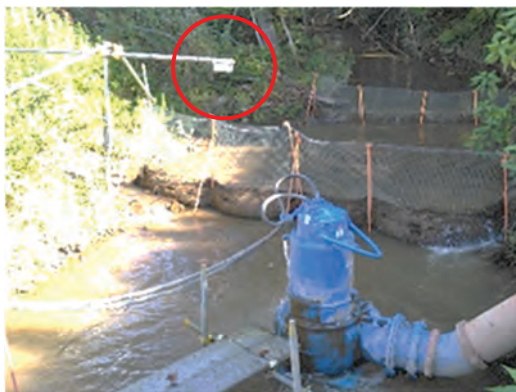
写真-3 水位計設置状況
