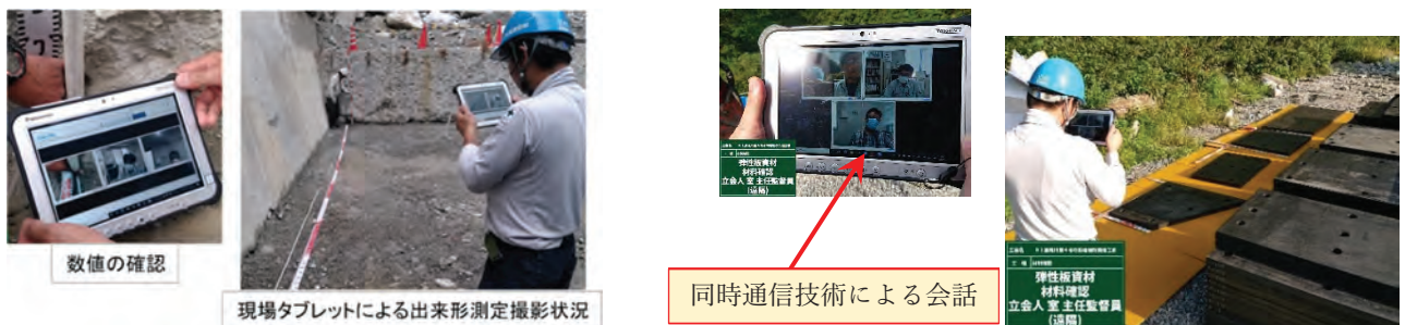
写真-11 遠隔臨場による出来形測定状況（受発注者間） 写真-12 遠隔臨場による材料確認状況（受発注者間）
