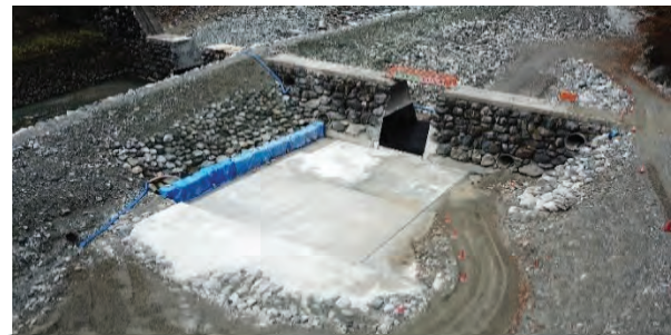
写真-2 黒蘆川第4号砂防堰堤(完成)
