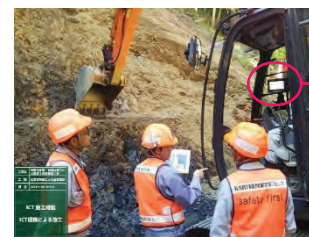
写真 3. 掘削時精度確認
