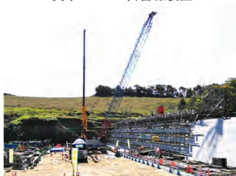
写真-10 クレーン打設状況
