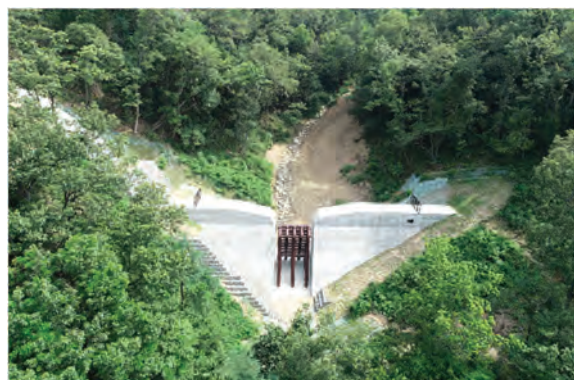
写真-2 工事完成
