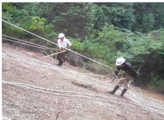
【法面整形作業風景】
