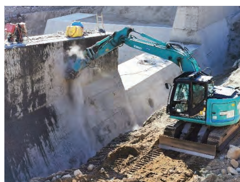
写真9 コンクリート切削機によるチッピング
