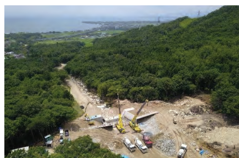
写真8 現場上空ドローン空撮
