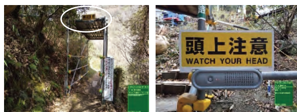
写真-8 防護柵とトークナビ設置
