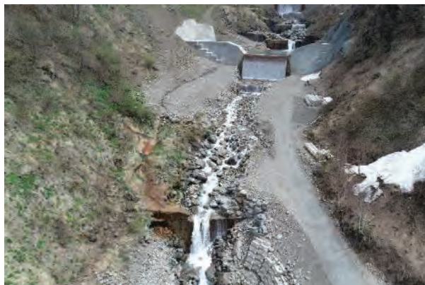
( コンクリート堰堤工 / 着工前 )
