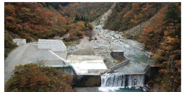
写真-3 黒蘆川第2号下流砂防堰堤(完成)
