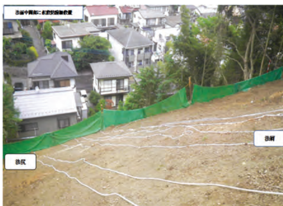
【法面中間部に仮設防護柵設置】
