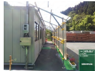
写真 24. ひさしの設置
