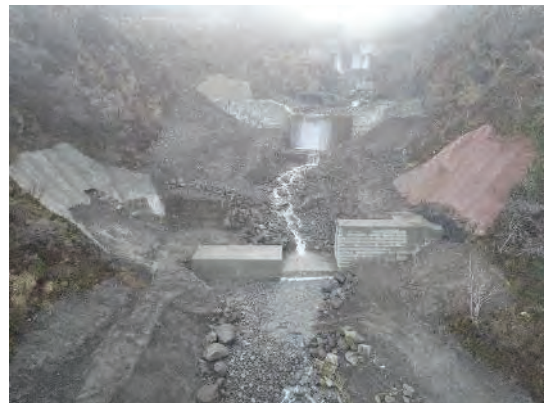
( コンクリート堰堤工 / 完 成 )
