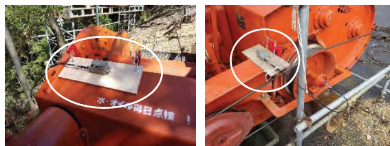
写真-4 距離カウンター設置
