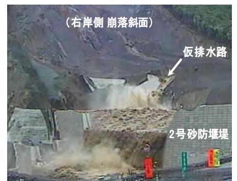
写真-3 越流状況(平成26年台風11号)
