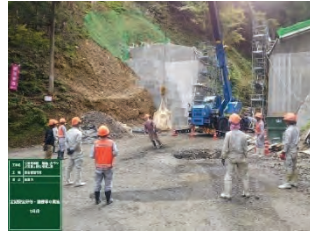
写真7. 吊り荷との接触実験
