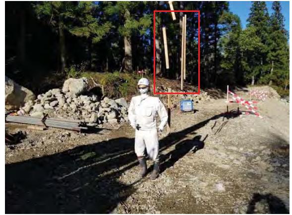
写真8 実際に資材が落下する
