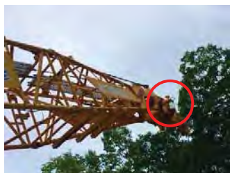
【カメラ取付状況】
