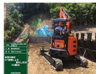
【I C T 建機による本堤内部材敷均し】
