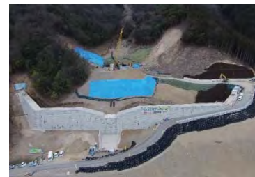
【作業ヤード完成】
