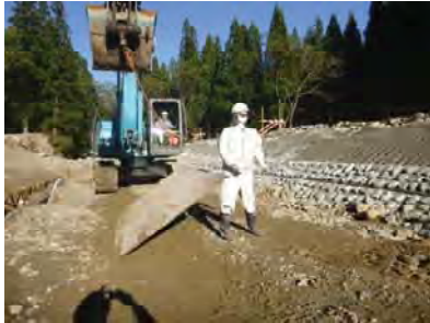
写真12 被災状況（訓練）
