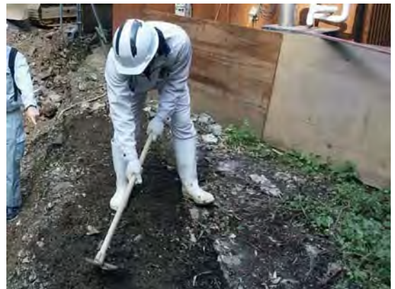
写真-5 人力作業状況
