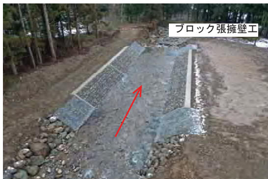
写真1 3工区完成写真
