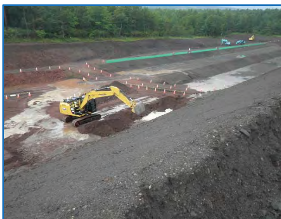
写真-5 立入禁止措置 (カラーコーン)
