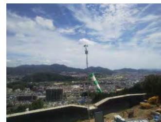
【風速計設置状況】
