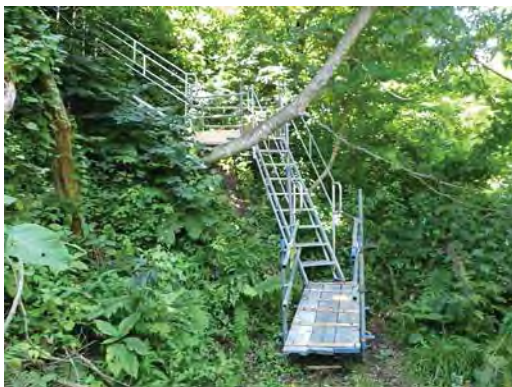
写真-8 昇降設備・避難訓練状況
