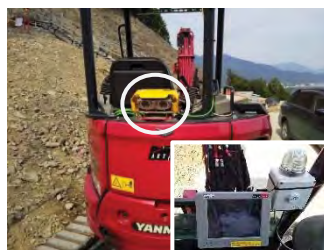
【機器取付状況】
