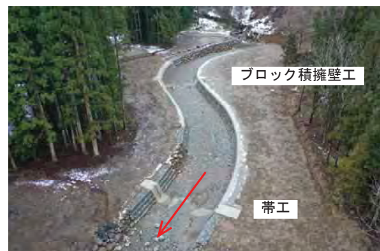
写真2 4・5工区完成写真
