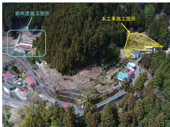
図-1 殿野地区施工箇所周辺状況
