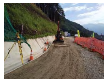
【I C T 建機による路盤敷均し】
