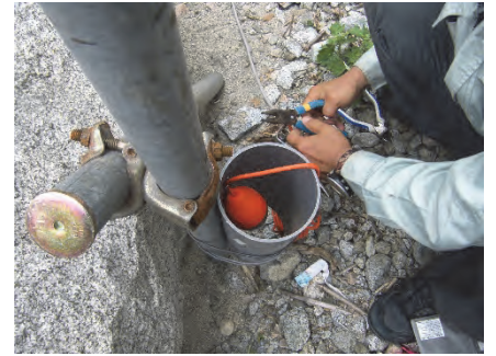
フロート式水位計設置
