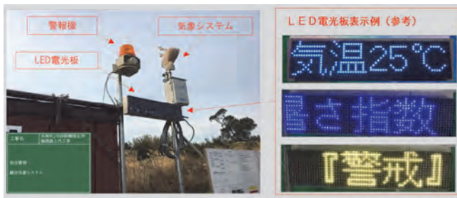
図-4 総合気象システムと情報の見える化
