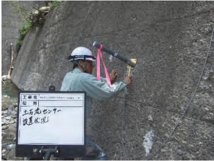
1 1号堰提側壁へ設置
