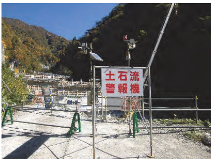
土石流 警報器 (受信機)
