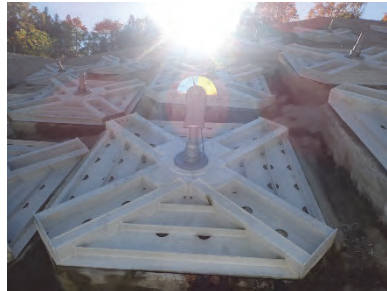
写真-8 施工1年後
