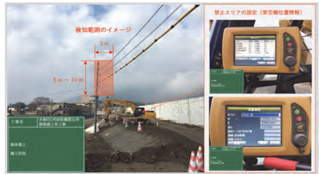
図-6 架空線検知範囲のイメージ
