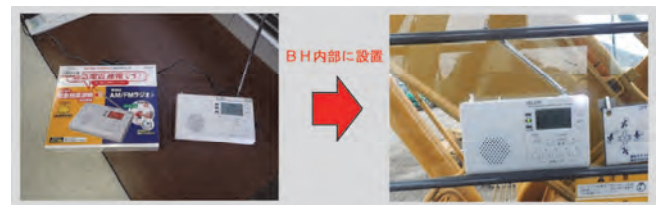
図-3 緊急地震速報機の設置
