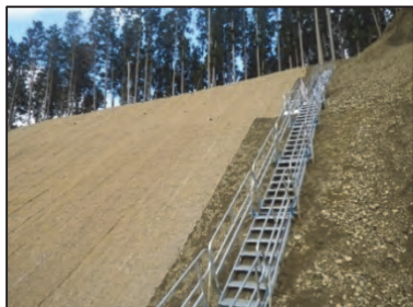
写真-3 掘削箇所の昇降設備
