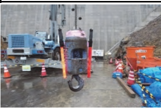
クレーンフック部に誘導灯設置 写真1
