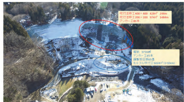
写真-2 工事概要 (平成28年12月撮影)
