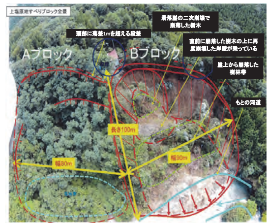
写真-1 地すべり発生状況
