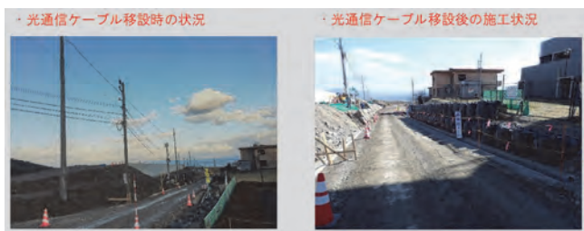
図-5 施工状況（図-1 断面付近）
