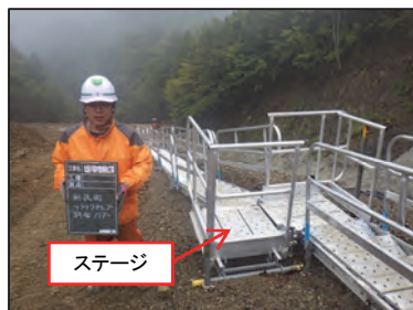
写真-4 盛土箇所の昇降設備
